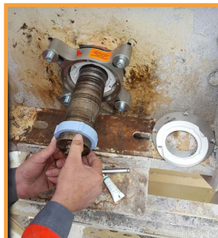
RotorCup y RubberBoot instalados.
